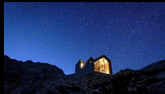
Alpine Hut Bivak pod Skuto Zgornje Jezersko, Slovenia GPI = 9109618
